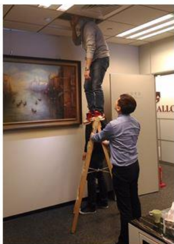
輕鋼架天花板配線作業，記得要先斷電。
