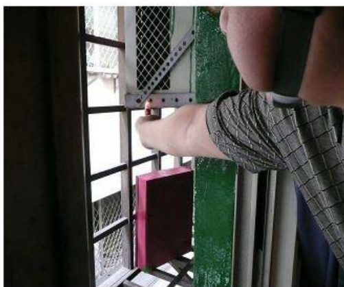
室外冷氣機會漏電，作業前要先檢電。以驗電筆檢測冷氣機外牆機殼時，燈號閃爍即表冷氣機漏電。
