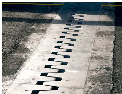
▲圖 1-6 橋樑之伸縮縫是為了預防橋樑因熱膨脹而引起變形之用。
